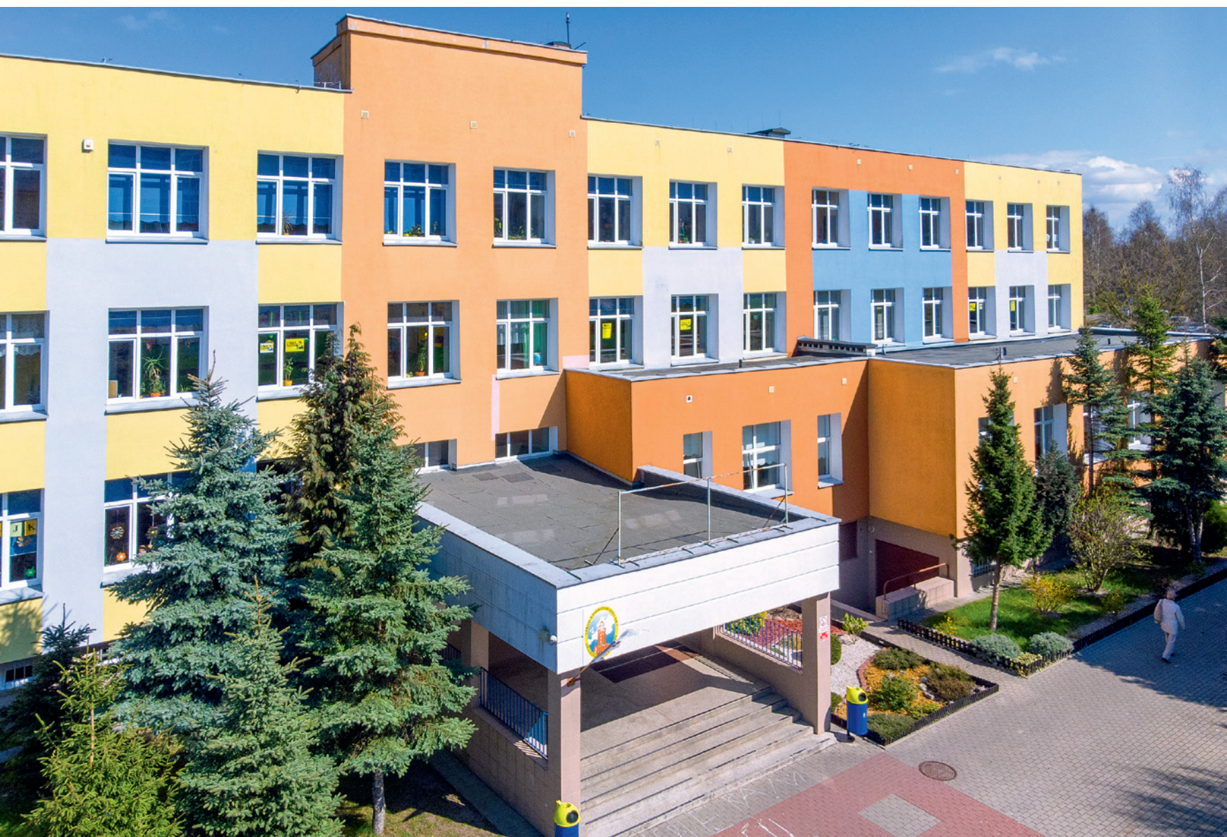
Budynek szkoły przy ul. Okopowej
